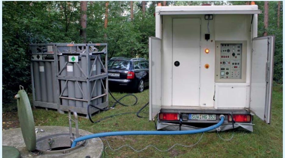
Bild 5 Durch Comprex-Einheit gesteuerte Einspeisung von Druckluft und Stickstoff in Brunnenleitung
