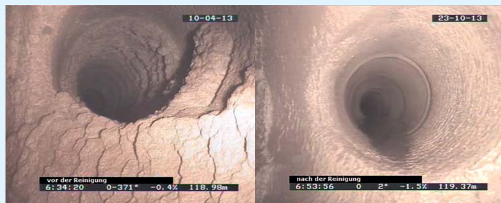
Bild 8 Wirksamkeit der Complex-Reinigung an Brunnenanschlussleitungen DN 200 Foto: BWB
