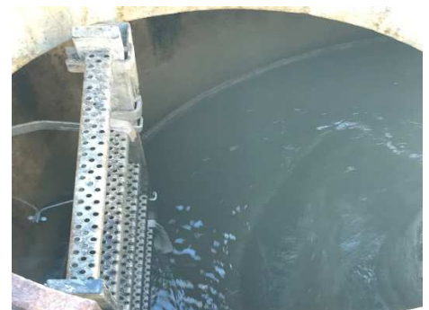
Abbildung 3: Austrag am Schacht
