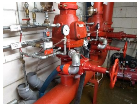
Abbildung 2: Zugang zu System über standardisierte Adapteranschlüsse
