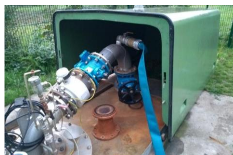
Abbildung 2: Zugang zum System via standardisierter Adapteranschlüsse
