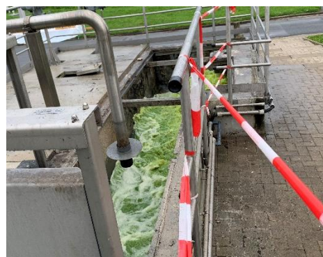
Abbildung 3: Ausspeisestelle der Spülstrecke
