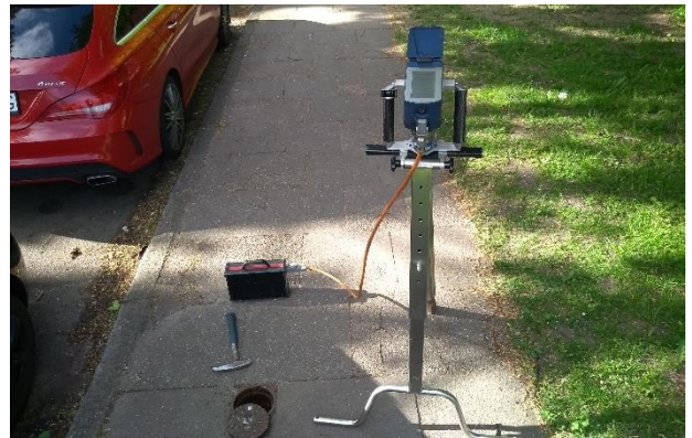
Abbildung 1: Schieberdrehgerät im Einsatz
