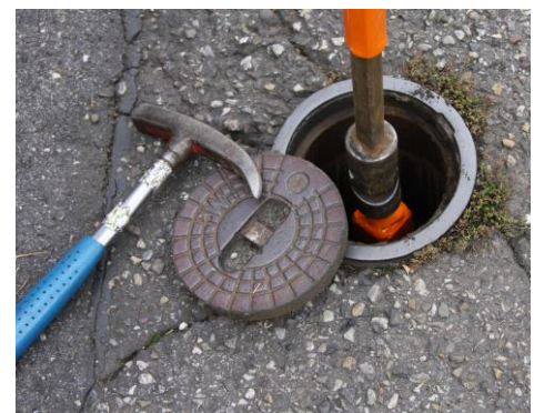
Abbildung 3: Schieber während der Inspektion
