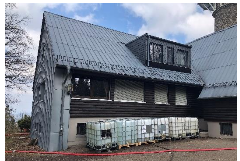
Abbildung 3: IBC-Container mit Spülwasser
