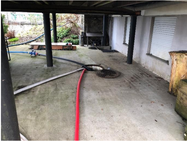
Abbildung 5: Einsehung von Luft und Spülwasser in Abwasserschacht
