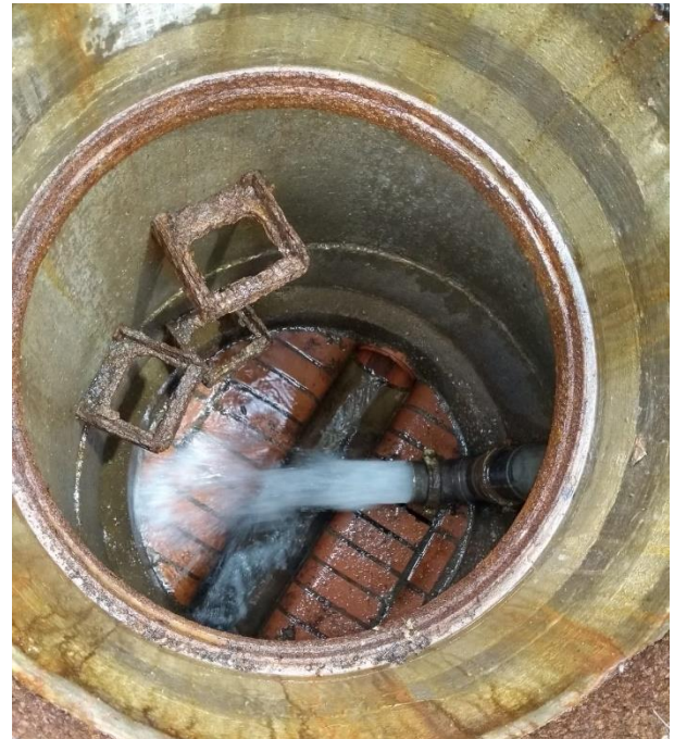
Abbildung 8: Klares Wasser an der Ausseisestelle am Ende der Complex®-Reinigung
