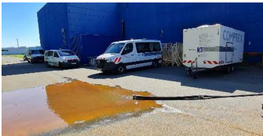
Abbildung 1: Comprex®-Unit und Ausspeisestelle vor dem Gebäude
