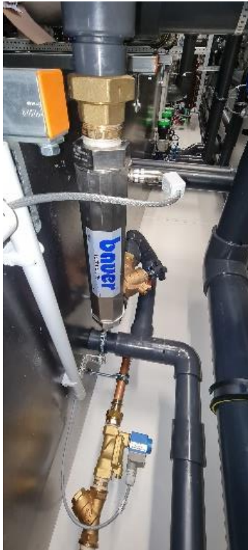
Abbildung 9: Kühlwasserbehandlung mit L&R Modul mit Technik von Bauer WT Systems und Hochleistungsfiltration
