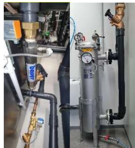
Abbildung 9: physikalische Wasserbehandlung (Bauer)
