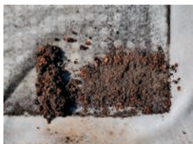
Ablagerungen vor der Reinigung & Feststoffaustrag nach der Reinigung
