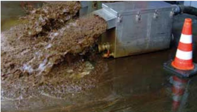
Abb. 10: Ausspeisung des Spülwassers über Spülboxen während der Complex-Reinigung von Vor- und Rücklaufleitungen DN 250
