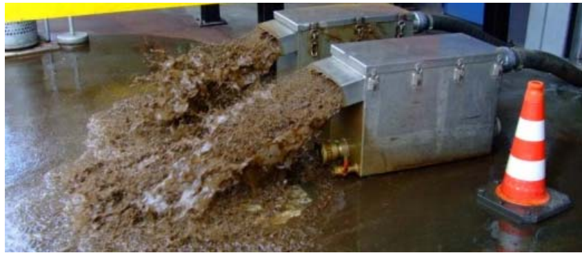
Abbildung 1: Ausspeisestelle mit Spülboxen
