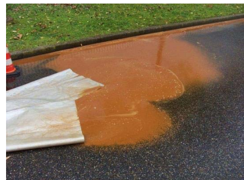
Abbildung 3: durch ausgetragene Ablagerungen verfärbtes Spülwasser am Auslauf
