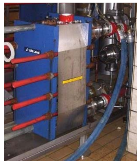
Abbildung 2: gedichteter / geschraubter Plattenwärmeübertrager (Symbolbild)
