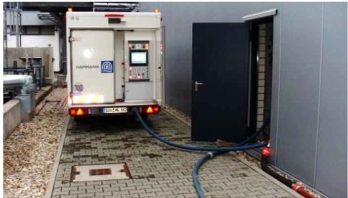
Abbildung 1: Comprex®-Einheit im Einsatz
