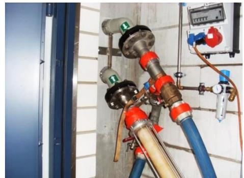
Abbildung 2: Ein- und Ausspeisung von Luft und Wasser über Adapter
