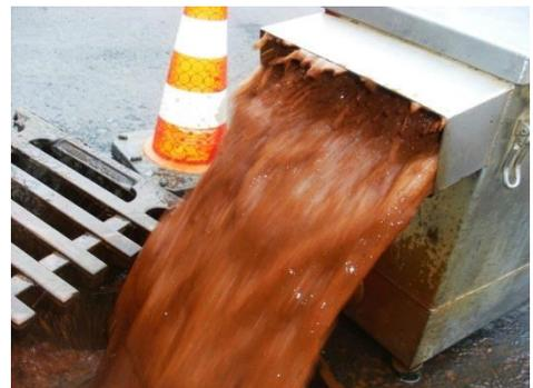
Abbildung 4: Trübung des Spülwassers an der Ausspeisestelle (Auslaufbox)
