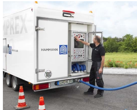
Abbildung 3: Comprex®-Einheit im Einsatz
