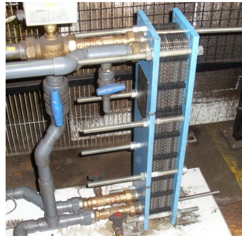
Abbildung 2: geschraubter Plattenwärmeübertrager im System
