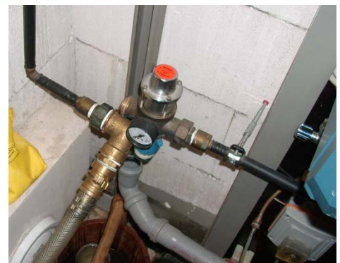
Abbildung 2: Einspeisung über Adapteranschlüsse
