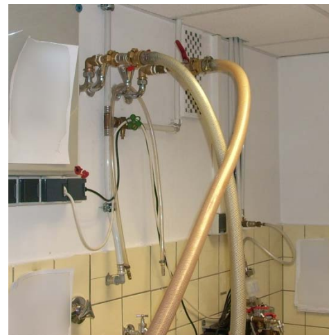
Abbildung 2: Einspeisung über Adapteranschlüsse
