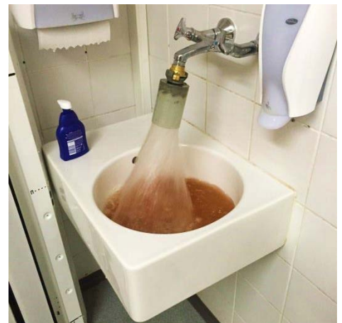
Abbildung 2: Trübung bei Ausspeisung über Waschbecken
