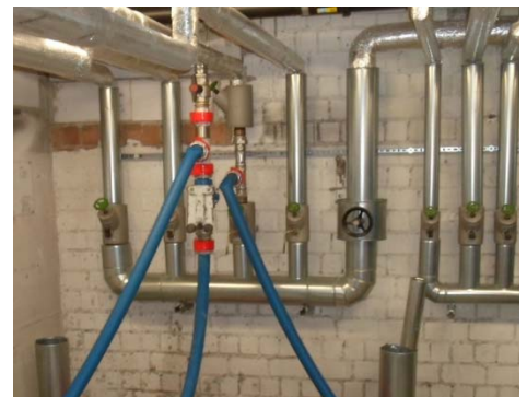
Abbildung 1: Einspeisung über Adapteranschlüsse
