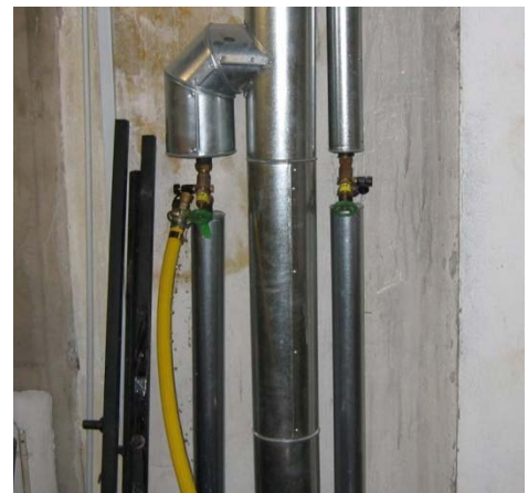
Abbildung 1: Einspeisung von Luft über Adapteranschlüsse
