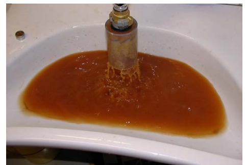
Abbildung 2: Trübung bei Ausspeisung über Waschbecken mit Zyklonabscheider
