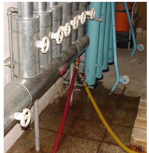
Abbildung 1: Einspeisung von Luft über Adapteranschlüsse
