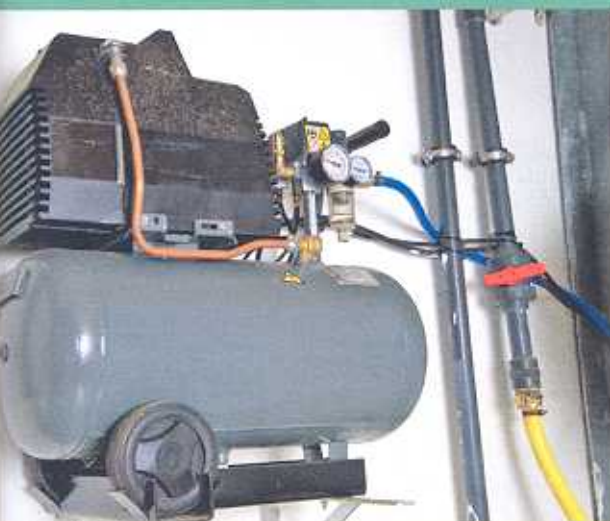
Wichtig: Die ins Tränkewasser eingespeiste Druckluft muss ölfrei sein!
