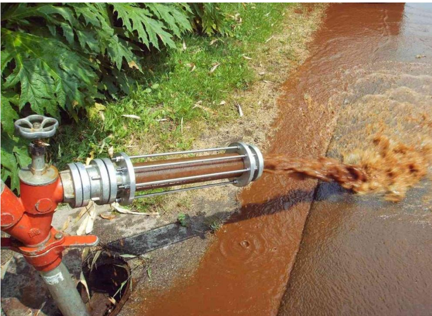
Bild 2: Austrag von Ablagerungen beim Impulsspülverfahren
