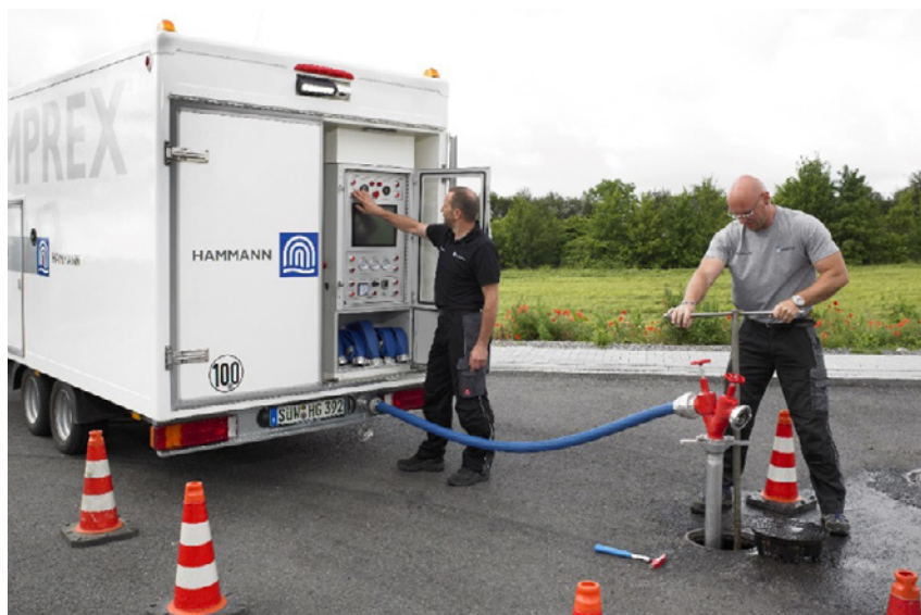
Bild 1: Konventionelle Comprex-Einheit bei der Rohrnetzspülung
