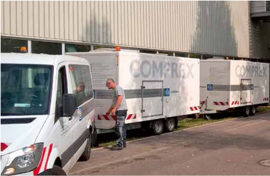
3 Nach dem Positionieren sind die Comprex-Einheiten bereit, mit Luftimpulsen Ablagerungen von den Innenwänden der KSS-Leitungen abzulösen und vollständig aus dem Rohrleitungssystem auszutragen (© Hammann)
