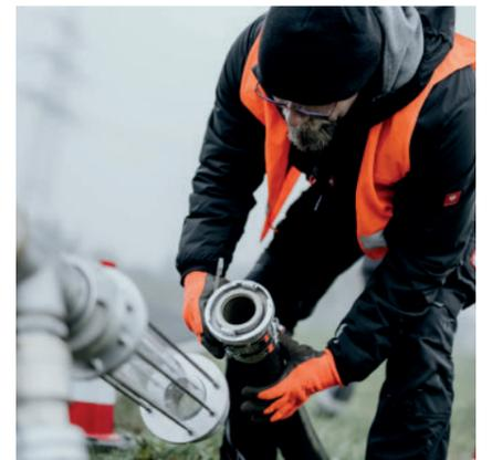
**Bild 6 Schauglas an der Ausspeisestelle zur Kontrolle und Dokumentation der Trübung.**
