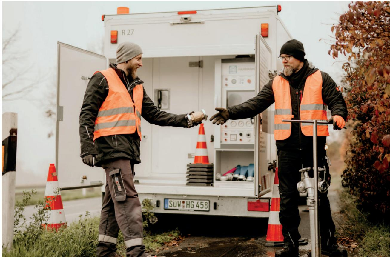
Bild 1 Mitarbeiter des Wasserversorgers und Hammann-Techniker vor dem Complex-Anhänger, der die Druckluftimpulse an der Einspeisestelle erzeugt.
