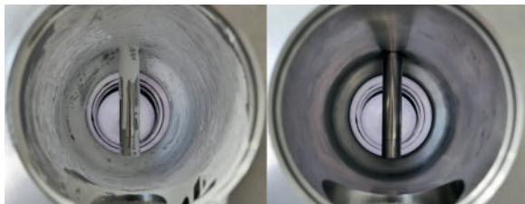
Abb. 4 // Molchstation vor und nach der Reinigung mit dem Impulsspülverfahren.
