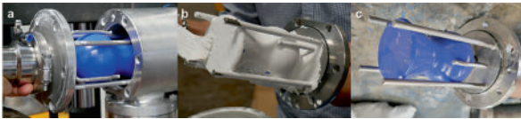
Abb. 8 // a) Molchstation, geöffnet zum Entnehmen des Molches, b) Molch nach Applikation der Dispersionsfarbe, c) Molch nach Reinigung.
