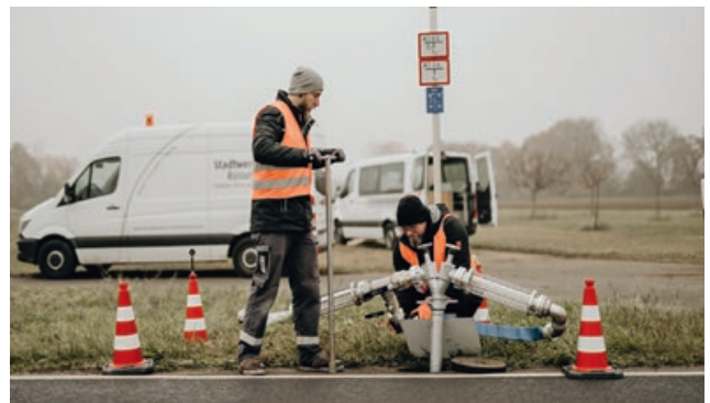
Abb. 2 – Einsatz des Impulspülverfahrens mit Druckluftdosierung (oben) und Ausspeisestelle (unten)
