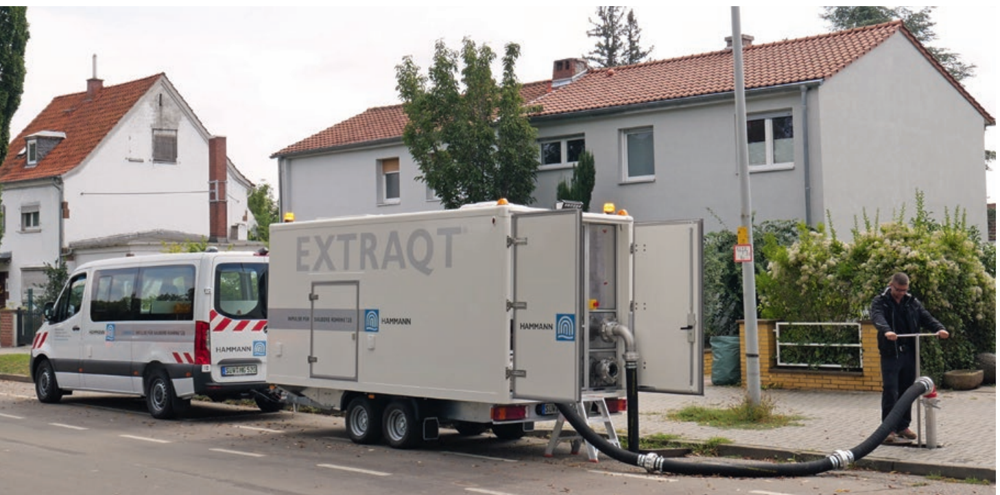
Abb. 4 – Wasser-Saug-Spülung im Einsatz
