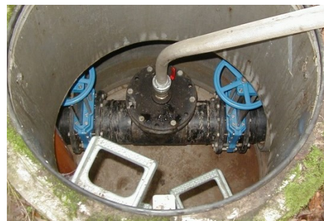
Abbildung 3: Einspeisung in Schacht über Adapter
