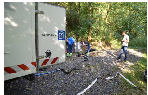
Abbildung 3: Einspeisung in Schacht
