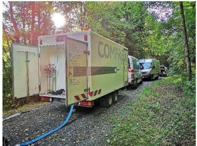
Abbildung 1: Compress®-Einheit im Einsatz
