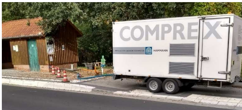
Abbildung 1: Einspeisepunkt am Pumpwerk
