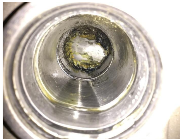
Abbildung 10: Blick ins Rohr durch Sondenzugang nach der Reinigung
