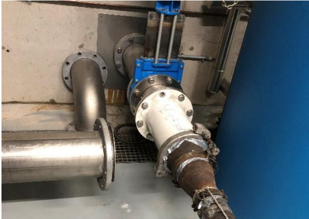
Abbildung 5: Auspeisung in Schachtbauwerk
