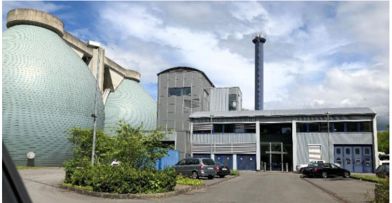
Abbildung 1: Klärschlammbehandlungsanlage (KSB) Langenbrahm
