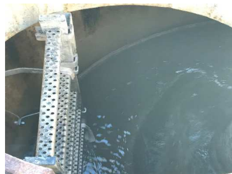
Abbildung 3: Austrag am Schacht
