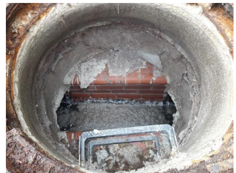
Abbildung 3: Austrag in Endschacht während der Reinigung
