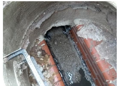
Abbildung 4: Austrag in Endschacht während der Reinigung
