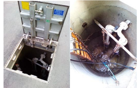
Abbildung 2: Schachtbauwerk im Straßenkörper (links), Pumpenschacht mit Anschluss für Spüleinrichtung
