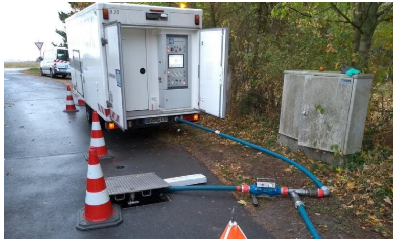
Abbildung 1: Complex®-Einheit im Einsatz vor Ort
