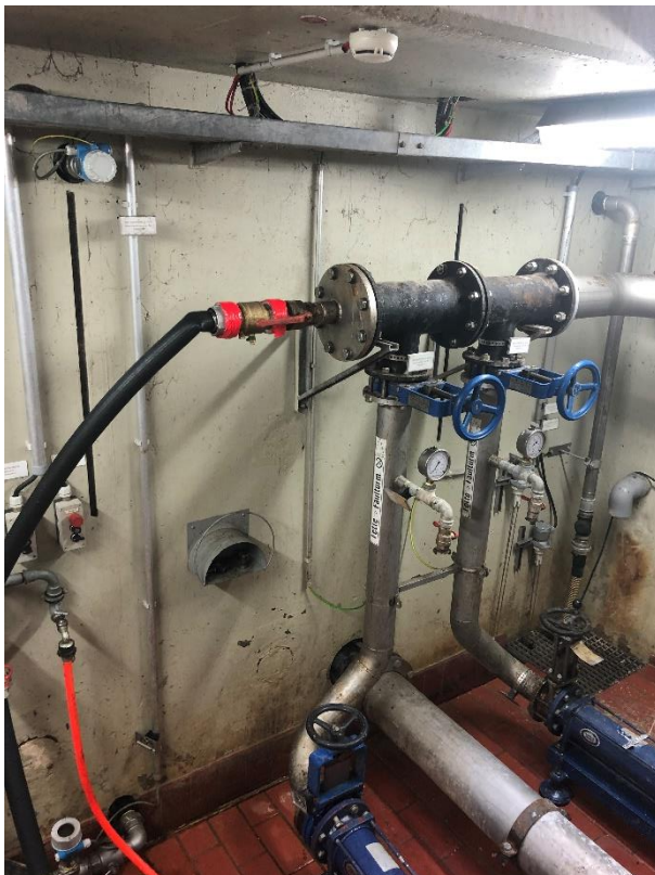
Abbildung 5: Einspeisung komprimierter Luft und Wasser über standardisierte Adapteranschlüsse
