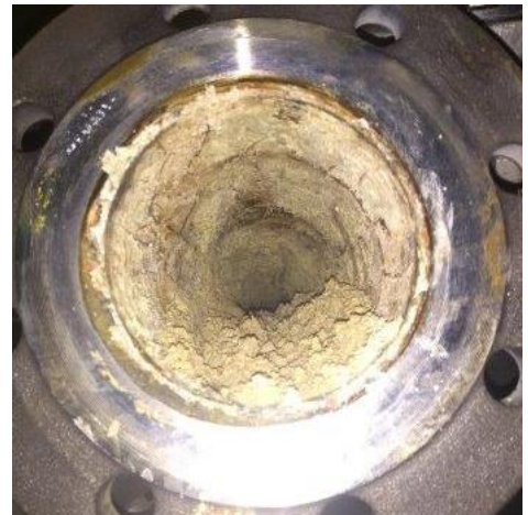
Abbildung 2: Fettleitung vor der Comprex®-Reinigung
