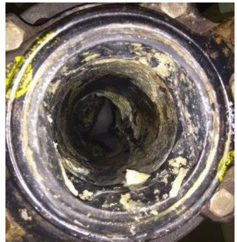
Abbildung 3: Fettleitung nach der Comprex®-Reinigung
