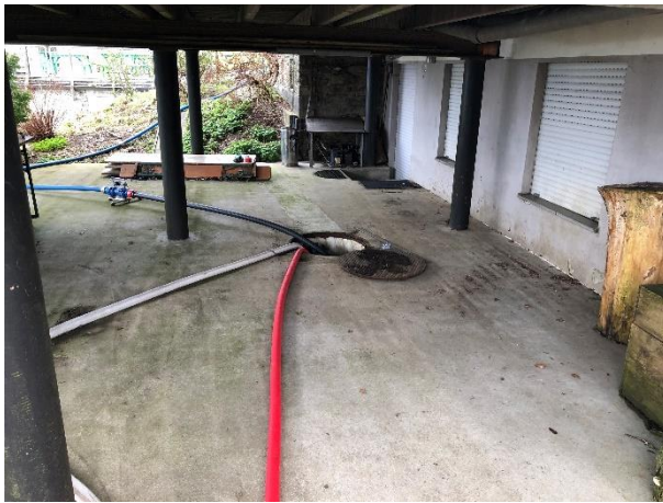
Abbildung 5: Einsehung von Luft und Spülwasser in Abwasserschacht
