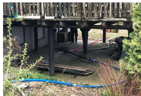
Abbildung 4: Zugang über Adapteranschlüsse und Schläuche
