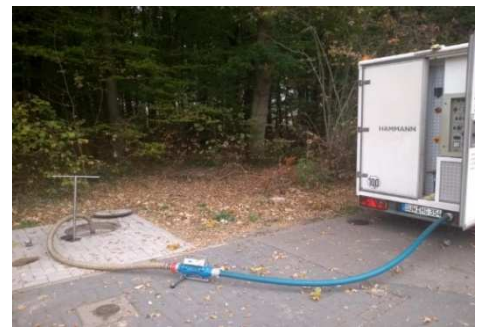
Abbildung 2: Comprex®-Einheit im Einsatz
