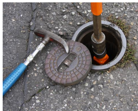
Abbildung 3: Schieber während der Inspektion
