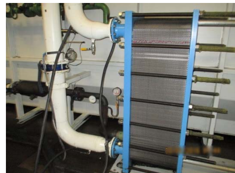
Abbildung 3: Wärmetauscher während der Reinigung
