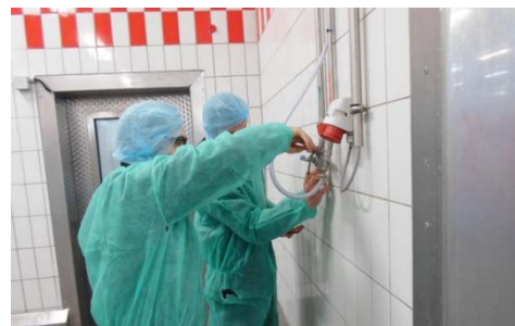
Abbildung 2: Herstellen der Schlauchverbindungen
