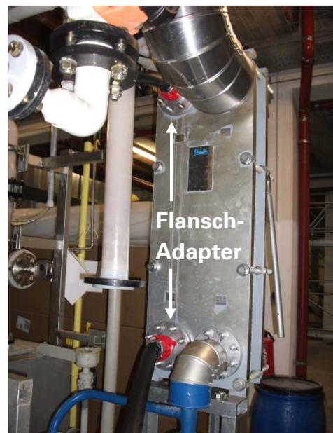
Abbildung 3: Comprex®-Reinigung eines Plattenwärmetauschers im eingebauten Zustand
