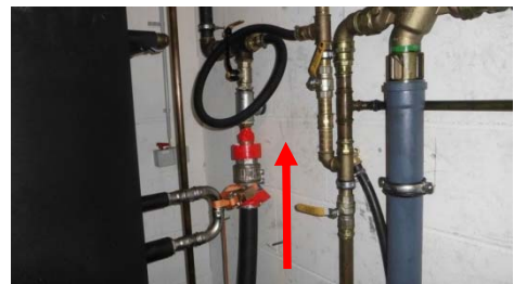
Abbildung 3: Druckluftspeisung über Adapteranschlüsse
