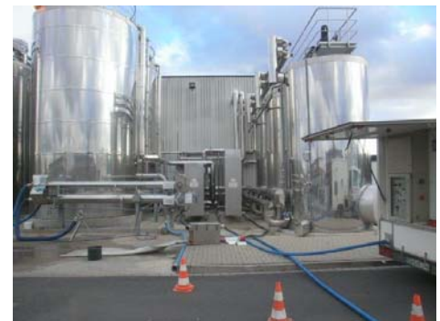
Abbildung 3: Comprex®-Technik vor Ort
