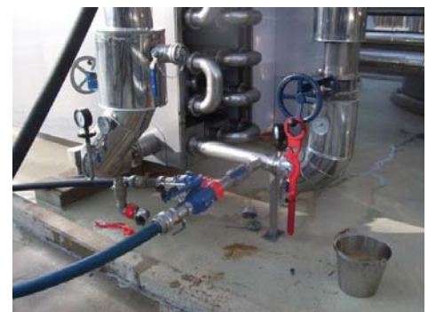
Abbildung 4: Einspeisung von Luft und Wasser über Adapteranschlüsse
