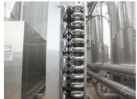
Abbildung 2: Doppelrohrwärmetauscher
