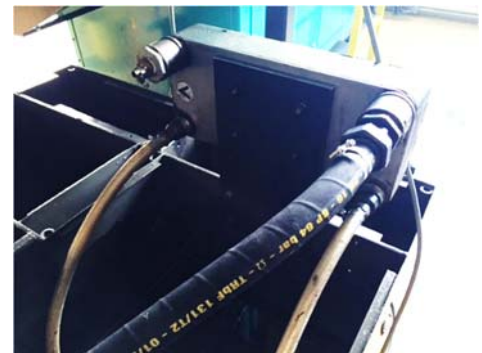
Abbildung 2: Plattenwärmetauscher während der Reinigung
