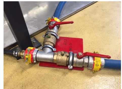
Abbildung 3: Einspeisung von Luft und Wasser über Adapteranschlüsse
