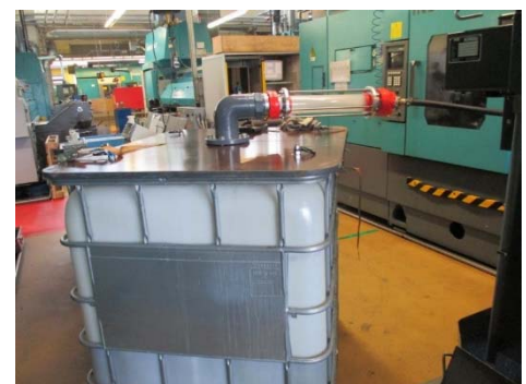
Abbildung 4: Ausspeisung von Spülwasser mit Ablagerungen in IBC
