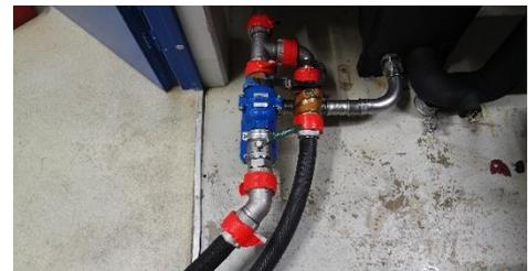
Abbildung 4: Adapteranschlüsse für Luft- und Wasserversorgung
