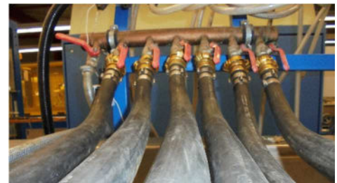
Abbildung 3: Ausspeisung über mehrere parallele Anschlüsse
