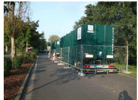
Abbildung 3: Sammelbehälter für Abwasser und Ablagerungen
