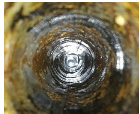
Abbildung 4: Kanaleingang nach der Reinigung
