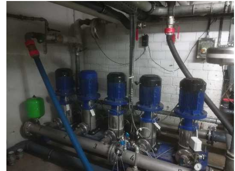
Abbildung 2: Vor- und Rücklauf des Kühlkreislaufes
