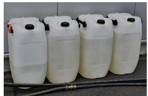
Abbildung 4: Auffangbehälter für das Kältemittel Antifrogen N
