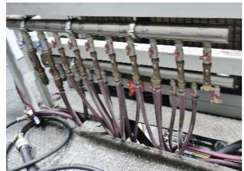
Abbildung 3: Verzweigung auf die neun Kühlkreisläufe
