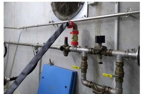
Abbildung 3: Standardisierter Adapteranschluss mit Rückschlagklappe (Symbolbild)
