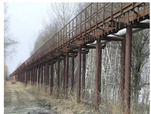
Abbildung 4: Rohrbrückenführung ([https://commons.wikimedia.org/wiki/File:Magnezium\\_Perchlor%C3%A1t\\_Mydlavary\\_2011-8.JPG](https://commons.wikimedia.org/wiki/File:Magnezium_Perchlor%C3%A1t_Mydlavary_2011-8.JPG))
